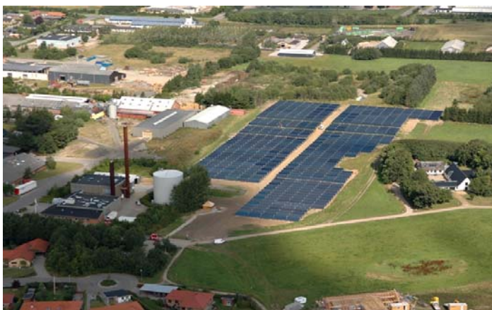
8.000 m 2 solvarmeanlæg i Brædstrup i Jylland
